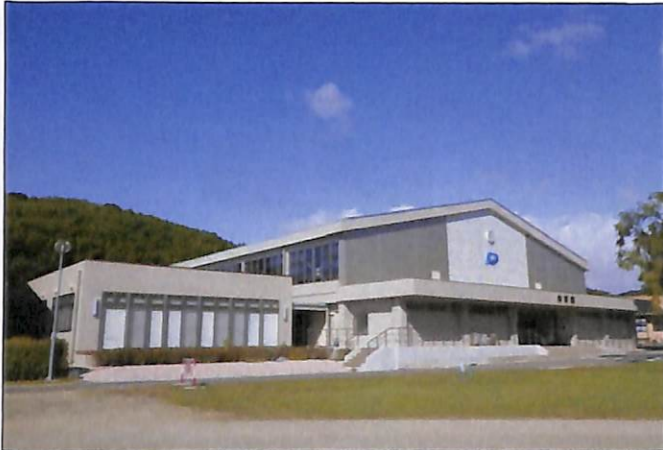
体育館 平成5年に外壁の塗装改修をしました。 平成24年度に改修工事をおこないました。
