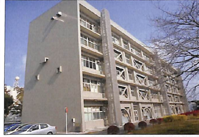
教育学部3号館 平成20年に、耐震補強工事をおこないました。
