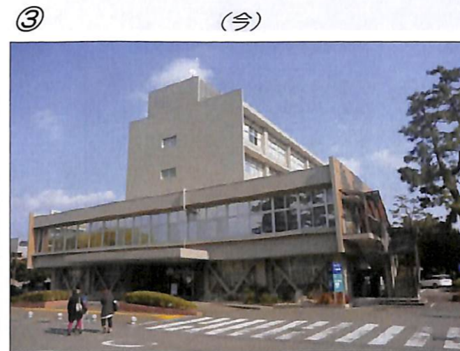
本部管理棟 平成19年に耐震補強工事をおこないました。
