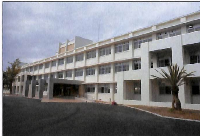
農学部 (昭和54年頃) 農学部1号館は、昭和41年から42年に 建設されました。 平成22年度に耐震補強と改修工事が完成しました。
