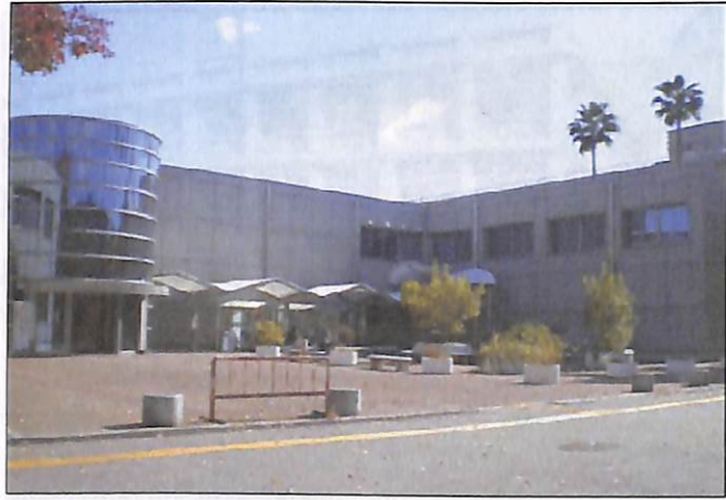
附属図書館 (メディアの森) 平成12年に、増築と改修工事をおこない、 メディアの森として再生整備されています。
