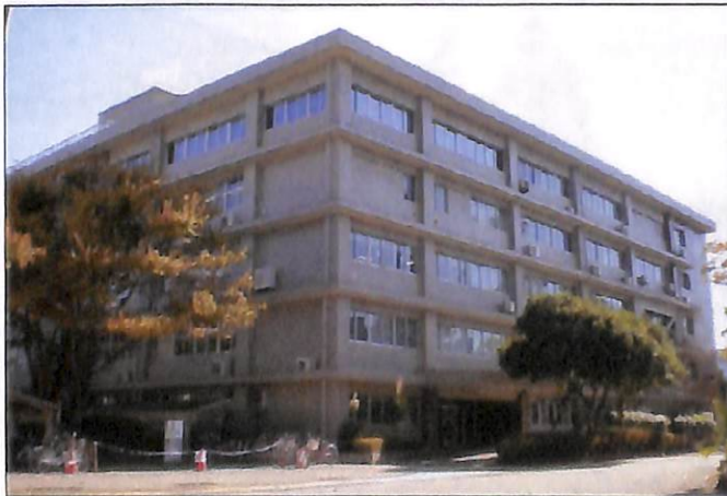
人文学部棟 昭和54年に建設された人文学部棟です。 平成19年には耐震改修工事をおこなました。
