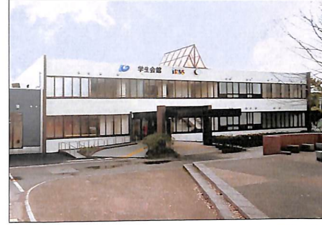
学生会館 平成21年に、増築と改修改修工事をおこない、 学生教職員と地域の方も多数利用しています。
